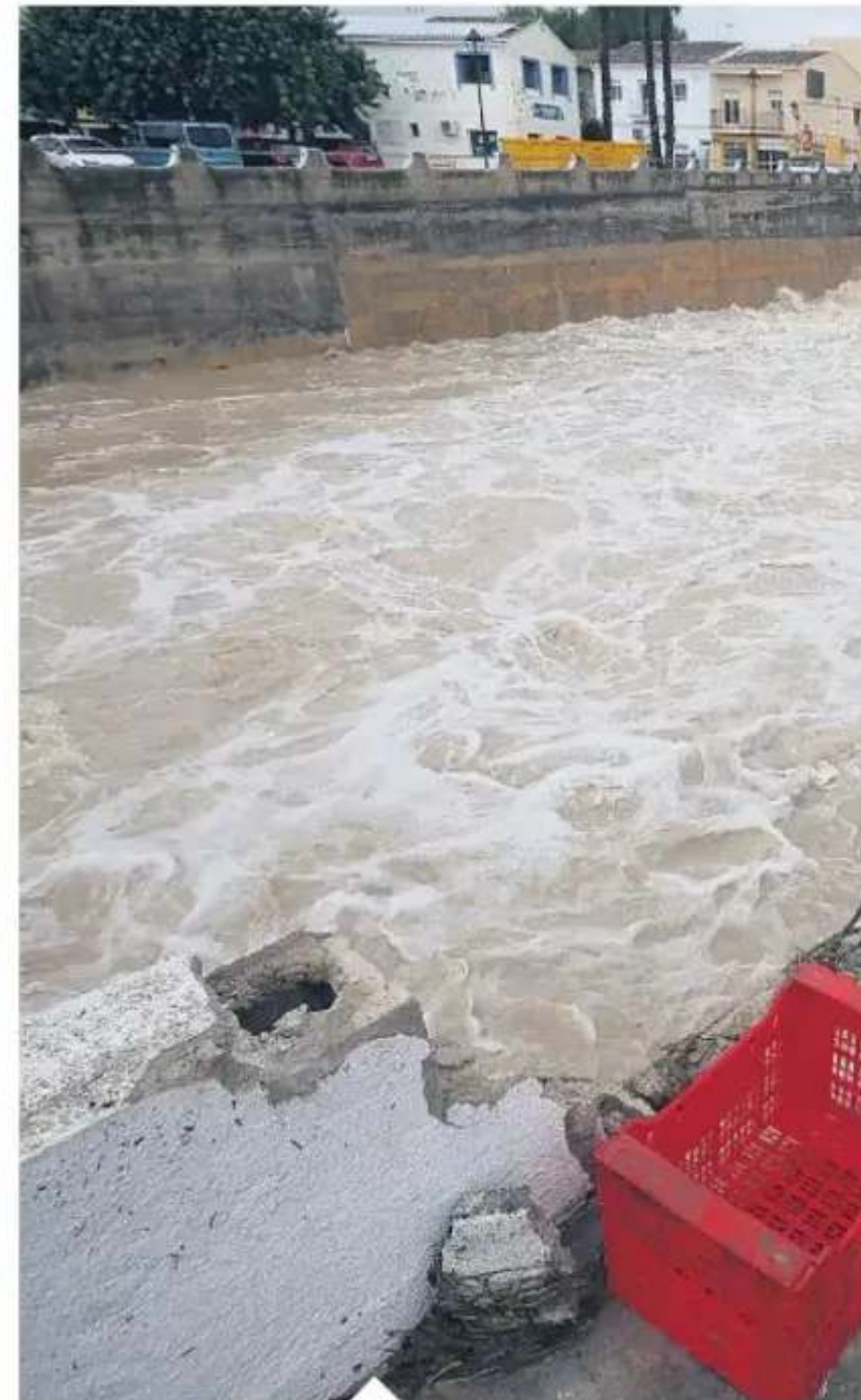
Vista de los destrozos provocados por las inundaciones en la localidad alicantina de Els Poblets
